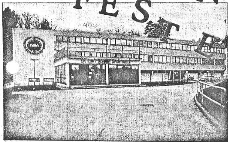
Gefährlicher Zwischenfall in der Postsporthalle – vier Verletzte
